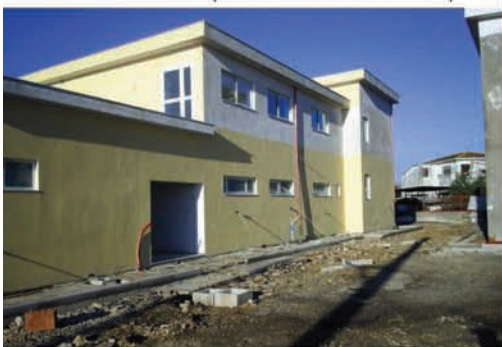
la stessa struttura a lavori conclusi
