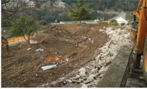
demolizione delle vecchie strutture esistenti
