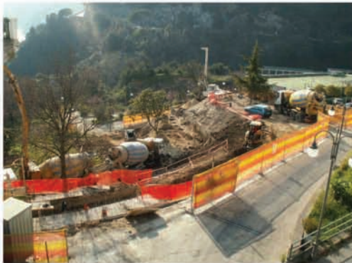
fasi di realizzazione delle strutture in c.a.
