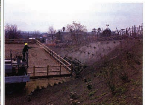
Lavori di idrosemina su scarpata adiacenti il campo di ippoterapia
