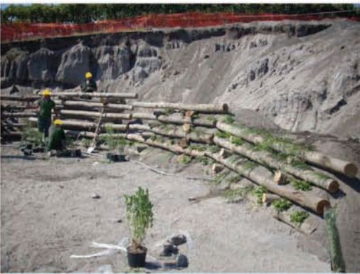
Lavori di realizzazione di una grata viva su scarpata
