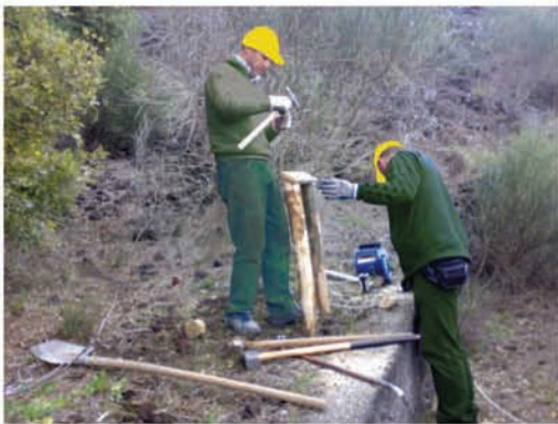
Lavori di realizzazione di una grata viva su scarpata
